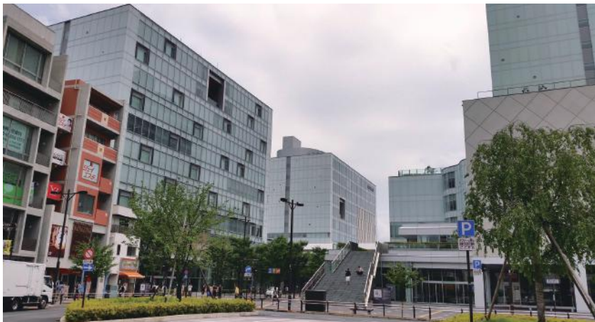
駅西口から見た商店街と、東口からみた大学群
